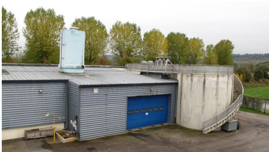
Photo 1. Vue des silos pré-épaisseurs et du local de traitement des boues.
