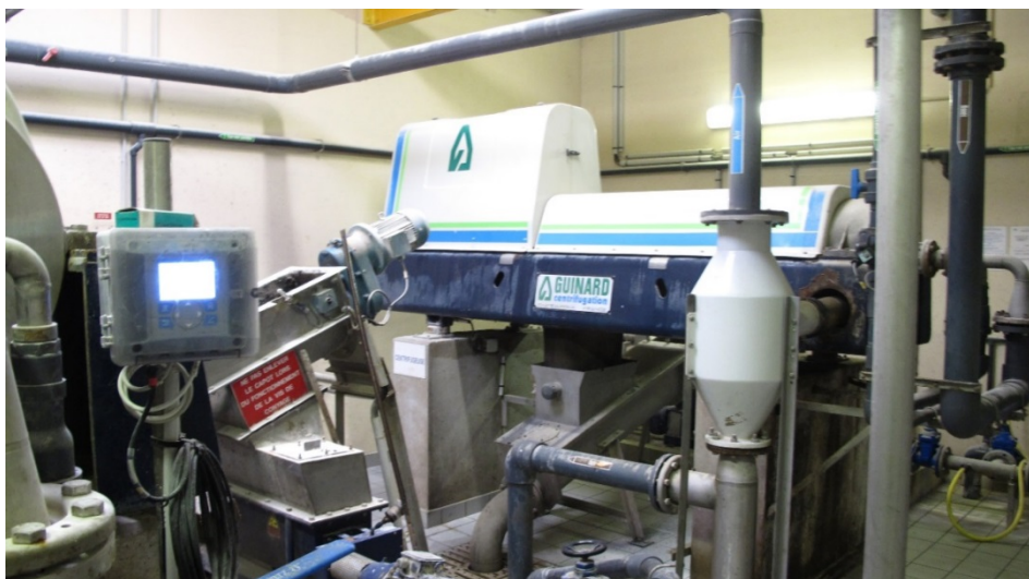
Photo 2. Vue des centrifugeuses et du dispositif d'adjonction de chaux.
