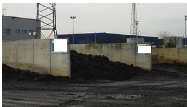
Photo 6 : Stockage des boues primaires
