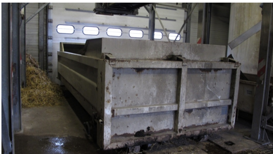
Photo 3. Benne de stockage et de transport des boues.
