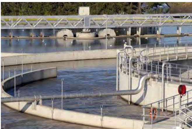
Station d'épuration (Fotolia)
